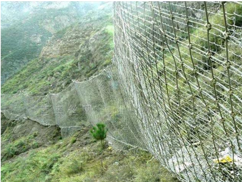
3). 河道边坡治理采用石笼网堆砌的方法
