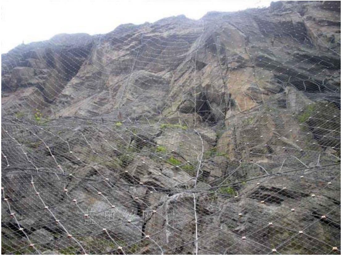
2). 安装被动防护网保护边坡
