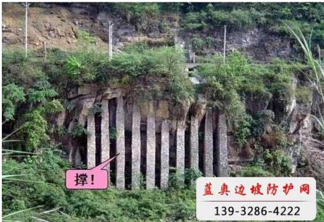
9). 边坡崩塌支撑垛防治
